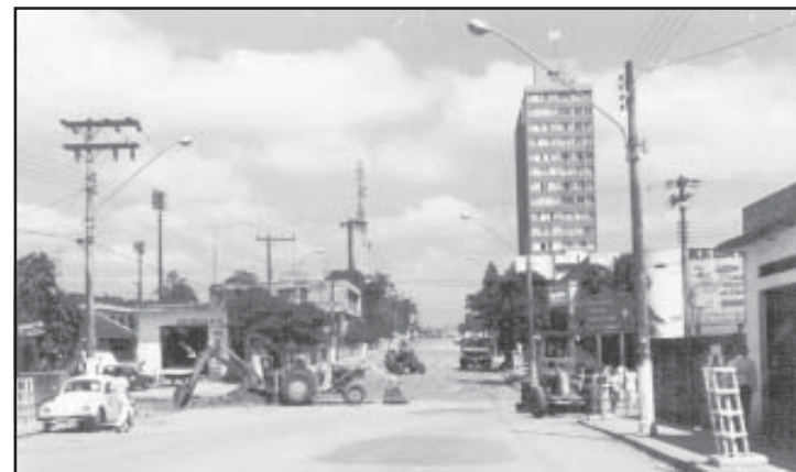
Pavimentação da Rua José Antônio de Campos. Como prefeito empreendedor, José de Carvalho virtualmente asfaltou todo o centro urbano de Registro.
