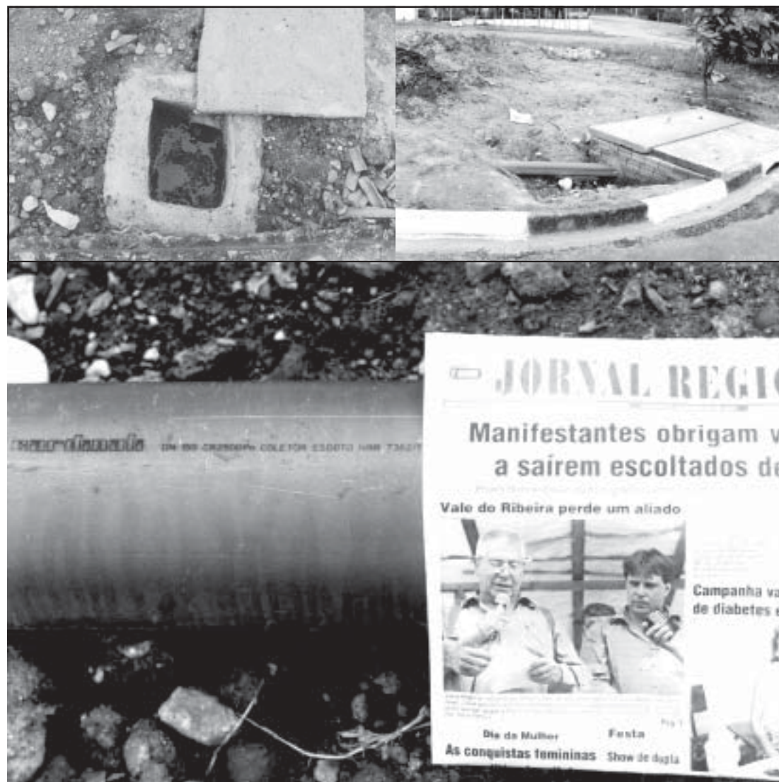
Apresentamos as fotos do local onde vazava o chorume cadavérico, cujas fotos fazem parte do Processo de Atentado do Local, onde a Prefeitura Municipal de Registro, faz reparos para prejudicar andamento da ação dos danos ambientais. Este processo encontra-se em apelação junto ao Tribunal de Justiça.
