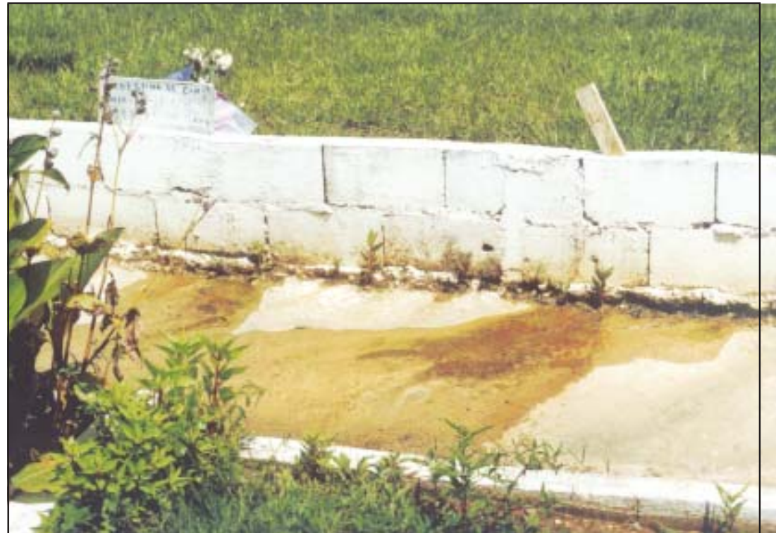
O “chorume cadavérico” vaza inclusive na via pública que dá acesso a entrada da Igreja Assembléia de Deus-Nosso Teto.
