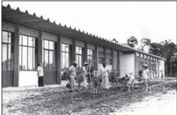
Construção do Centro Social Urbano em Registro, administração do ex-prefeito José de Carvalho
