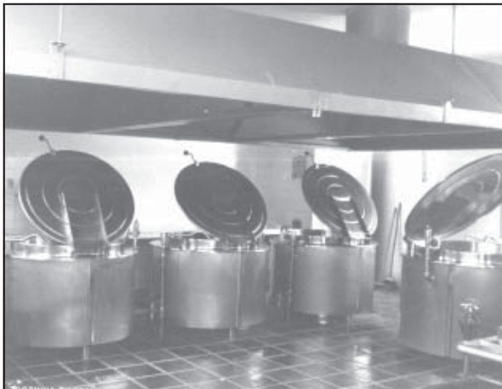
Construção da maior cozinha piloto que a região já conheceu, obra criada por José de Carvalho, o grande idealizador de Registro.
